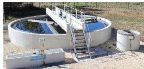
**Décanteur Digesteur :** La seconde fonction de cet ouvrage est d'assurer le stockage de boues. L'autonomie de stockage est de douze mois avant de partir en épandage agricole.
