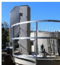
**Décanteur-Digesteur :** Cet ouvrage assure une double fonction. La première étant une fonction de prétraitement assurant une décantation primaire et une rétention des graisses. L'abattement garanti est de 30 % de la DBO5 (Demande Biologique en Oxygène).
