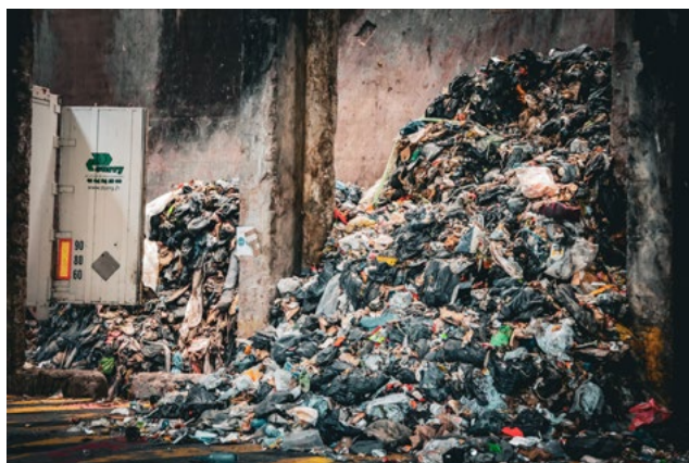
Unité de Revalorisation Énergétique à Arrabloy
